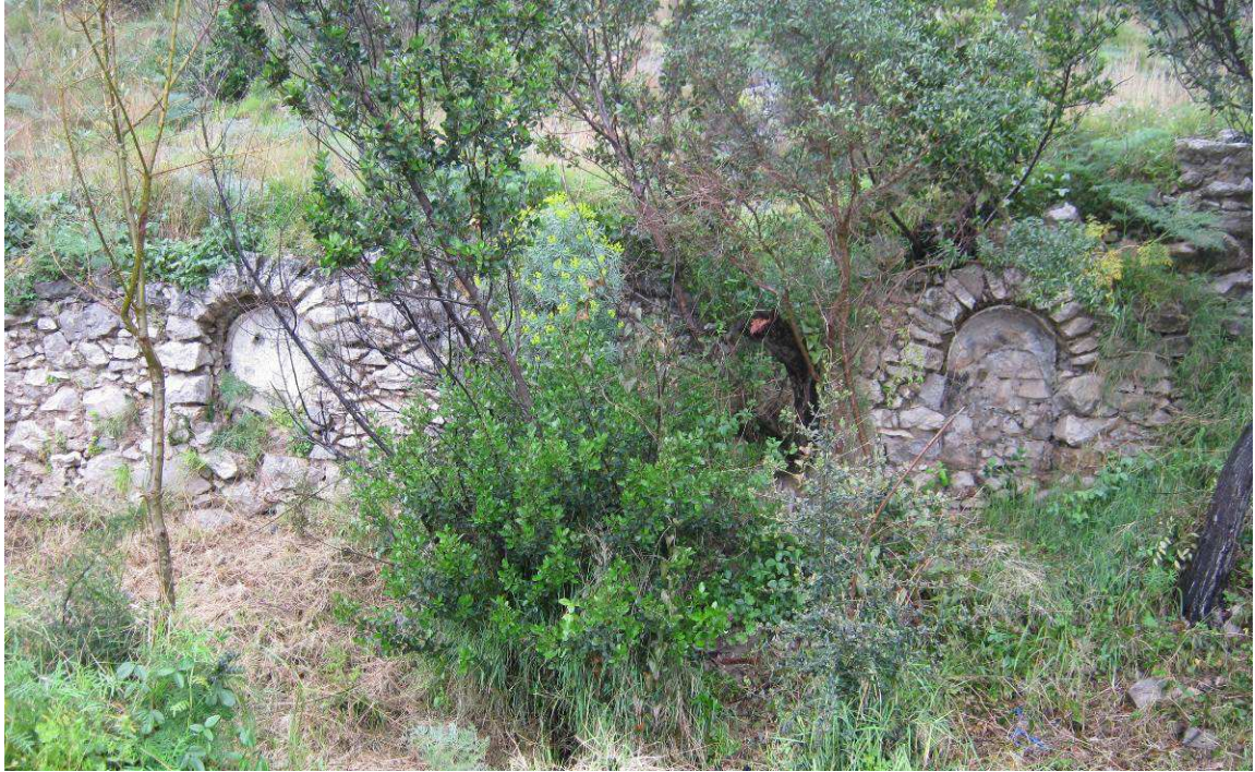
Figura 35 Le nicchie poste lungo il muro a nord del claustrum , Evidente la presenza di alcune tracce d’intonaco tinteggiato. Da sottolineare, inoltre, l’uso di conci calcarei più piccoli e regolari a partire dalle imposte degli archi (Foto F. Comes 2013)
